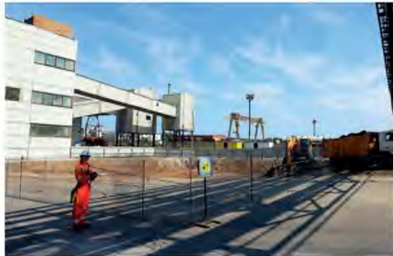
Продолжается устройство фундамента для подстанции
